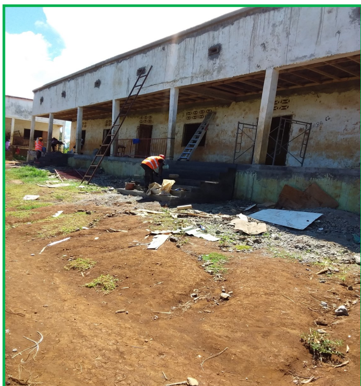
Ecole primaire publique de Sadapoini avant réhabilitation à Ndzواني
